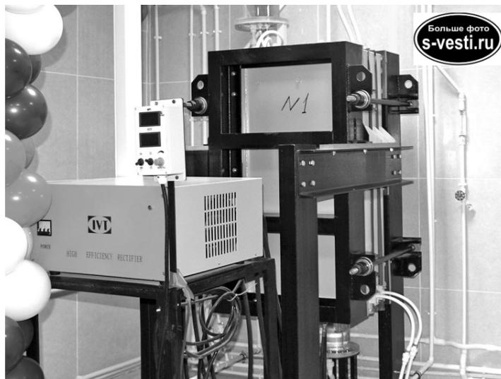
**Мембранно-электролизная система обеззараживания воды успешно выполняет свою функцию.**
