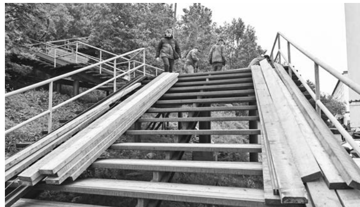
Отремонтированный трап от ул. Душенова, 26, к ул. Полярной уже радует пешеходов.
