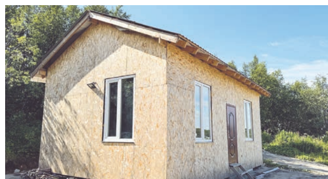
Начало положено: домокомплект уже установлен. Осталось доделать обшивку и можно жить.
