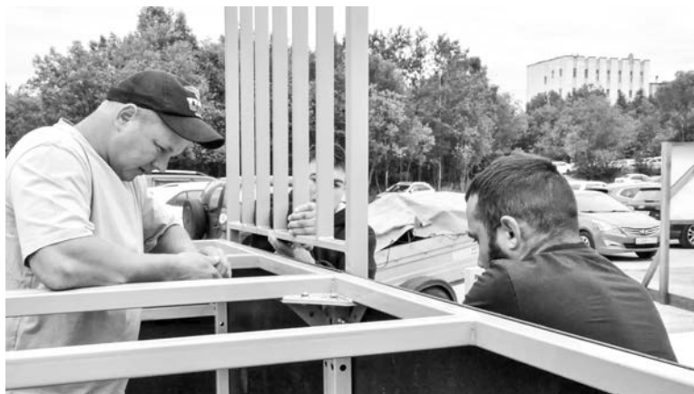
Специалисты «Угольного завода спортивного инвентаря» устанавливают уже третью скейт-площадку в нашем ЗАТО.
