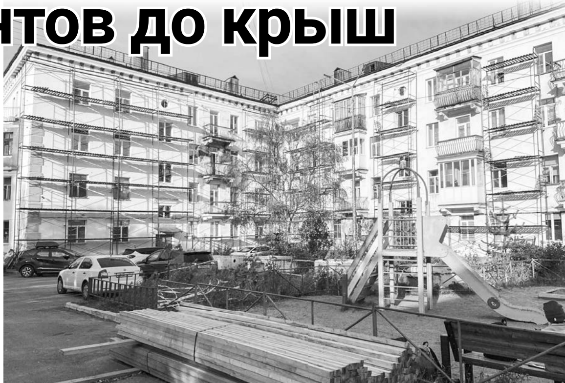
В доме по ул. Сафонова, 2, ремонтируют фасад и кровлю по программе реновации ЗАТО.
