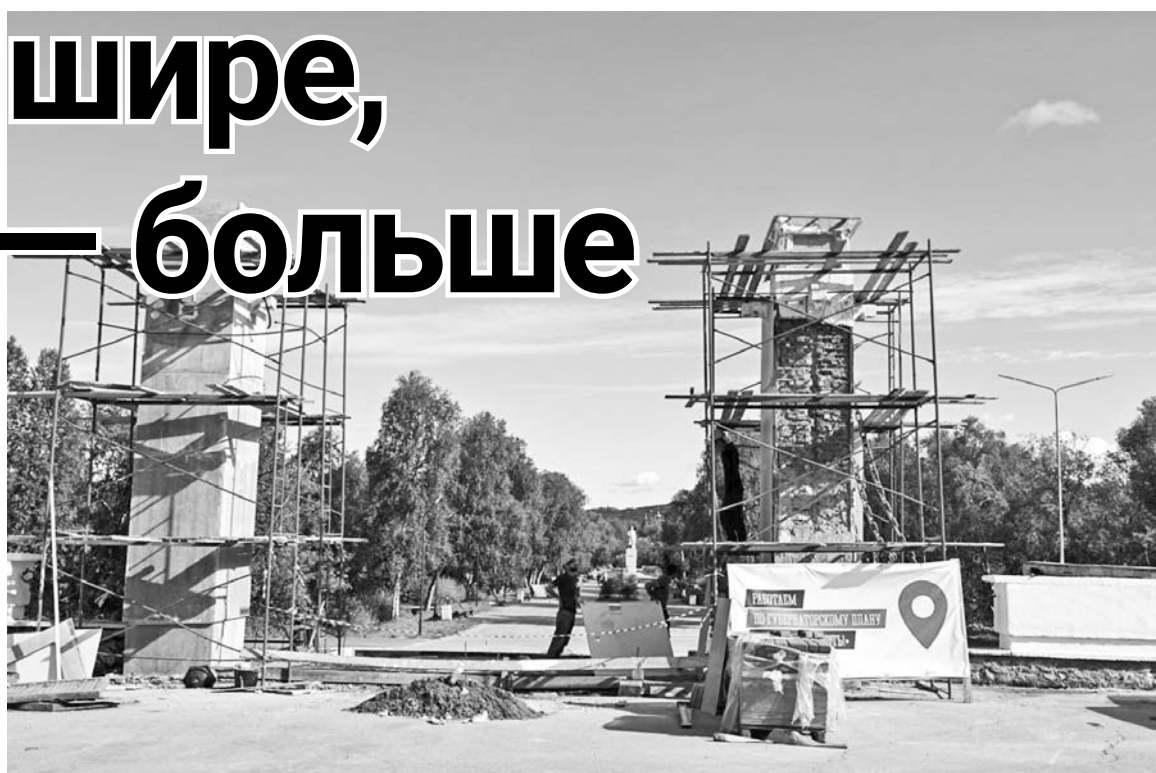
В активной фазе — ремонт входной группы. Рабочие обновляют колонны и кладут тротуарную плитку.
