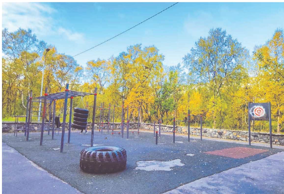
И прорезиненное покрытие, и оборудование на спортплощадке в городском парке в процессе эксплуатации пришли в негодность. Летом все заменят.
