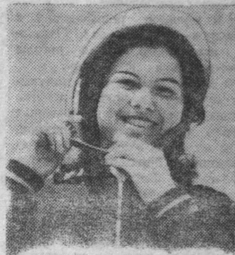
КИРГИЗСКАЯ ССР. Комсомолка Вера Гумина — строитель Токтогульской ГЭС. Фотохроника ТАСС.
