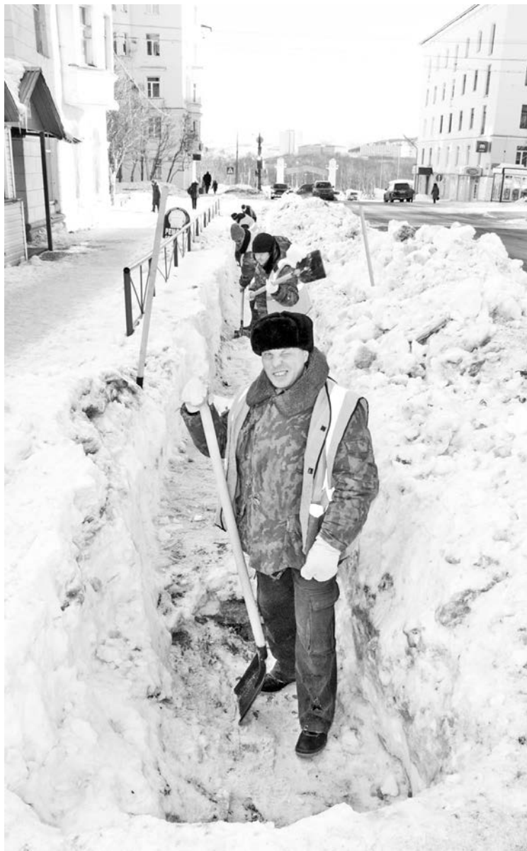
Андрей Николашин с бригадой дорожных рабочих очищают ливневые стоки на ул.Головки.
